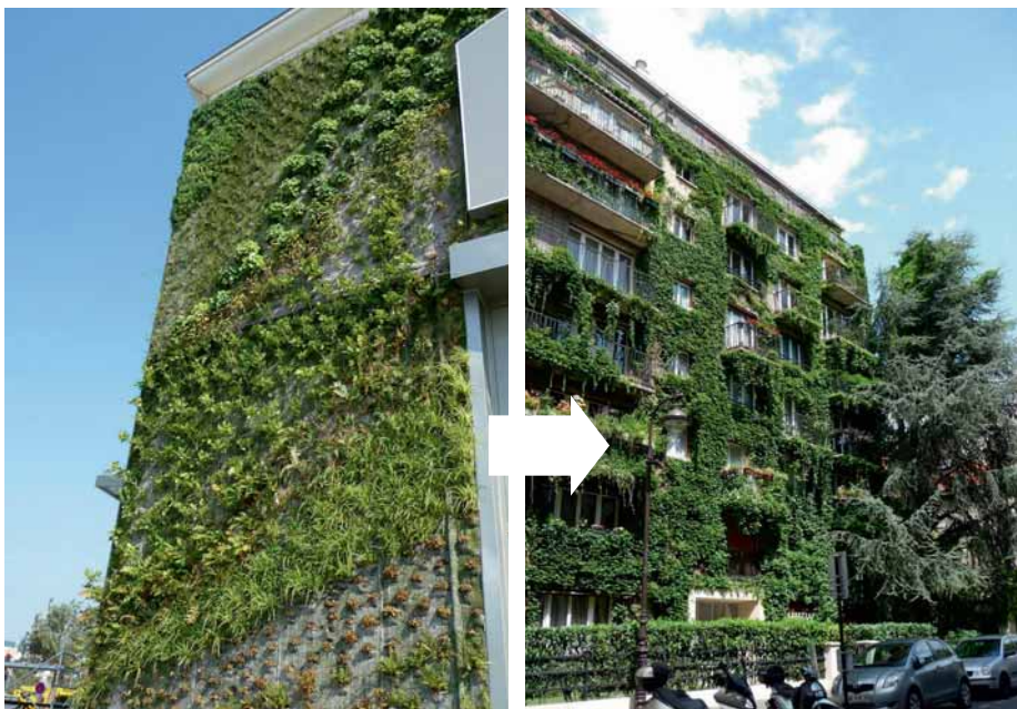
Les plantes grimpantes (à droite - Paris 13 e ), plus rustiques et moins coûteuses, sont à préférer aux murs artificiels (à gauche - centre commercial aux Clayes-sous-Bois 78).
