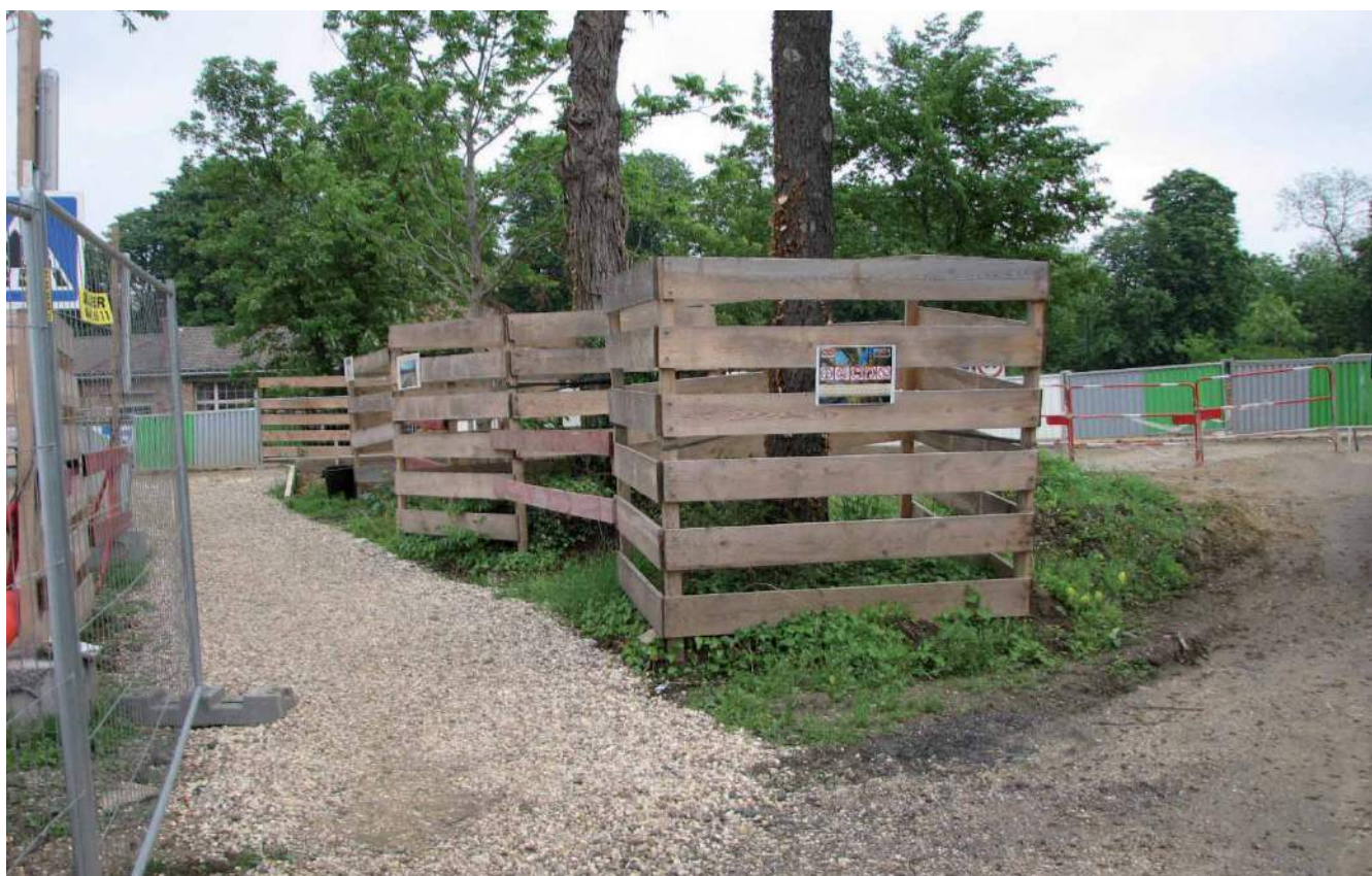
Les démarches de « chantiers verts » prévoient notamment la protection des arbres et de la végétation existante.
