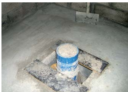
Le forage d'une profondeur de 30 m.
