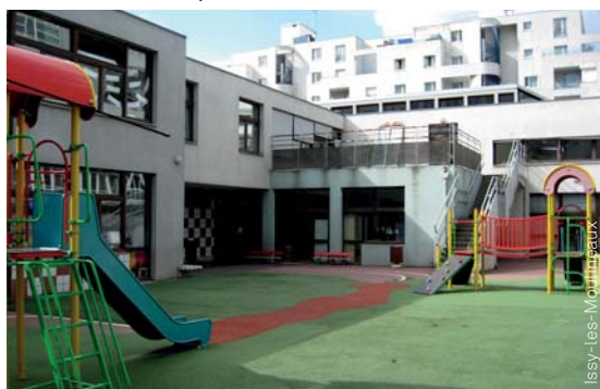
Groupe scolaire avant travaux
