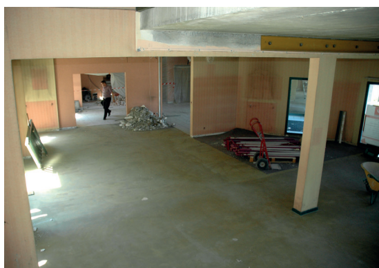
Médiathèque avant travaux
