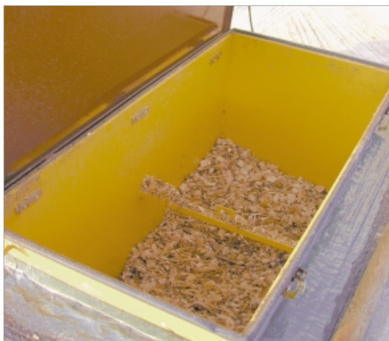
Trémie de stockage des plaquettes de bois.
