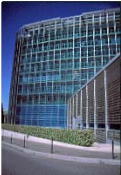
Les façades du bâtiment sont différentes selon ces orientations. La double façade sud est constituée de vantelles sérigraphiées pour assurer une protection solaire. Celle du Nord est fixe et protège le bâtiment du vent froid de l'hiver. Toutes les fenêtres de la façade intérieure s'ouvrent.. La façade sud est conçue de sorte que le total de transmission énergétique n'atteint que 14 %. La transmission lumineuse est, quant à elle, de 20 %, ce qui est largement suffisant.
