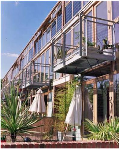
La partie vitrée extérieure peut être ouverte, mais elle est ombragée par la toiture avec une dalle de béton. Pour lutter contre les problèmes de pollution intérieure, la cuisine n'utilise pas de médium. L'apparence des compteurs d'eau et d'électricité a été améliorée; les chiffres sont très visibles, afin de pouvoir vérifier les niveaux utilisés.
