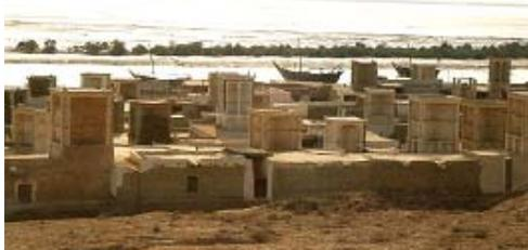
Le principe de ventilation naturelle est également illustré par les tours de vent situées dans le détroit d'Omar, en Perse. La tour de vent est un édifice massif bâti en terre dans lequel la brise marine pénètre. L'air frais et humide est alors emmagasiné. L'inertie restitue la température avec six à sept heures de différence, ce qui donne une impression de fraîcheur pendant la journée.
