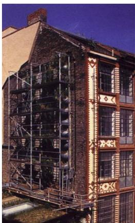
Cet immeuble de Berlin, sur sa façade pignon, met en œuvre un système de filtre des eaux grises au moyen de roseaux : ces eaux ressortent propres. Pour l'eau potable, il convient d'y adjoindre une machine qui assainit d'avantage ces eaux. Le second exemple concerne un ensemble de bâtiments au centre desquels se trouve un centre de traitement des eaux de forme pyramidale. Ce système est inconcevable pour des maisons isolées : seule une communauté d'utilisateurs peut le financer.
