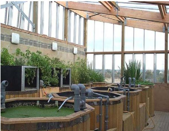
Les eaux usées sont traitées avec des plantes qui éliminent les odeurs. Pour rendre l'eau potable, il faudrait installer un système deux fois plus puissant. On pourrait installer des filtres osmotiques, mais cela nécessiterait de nombreux contrôles. Cependant, l'eau bue par les ménages ne représente que 5 % de leur consommation totale d'eau. Pour boire, il est préférable de récupérer l'eau de pluie.
