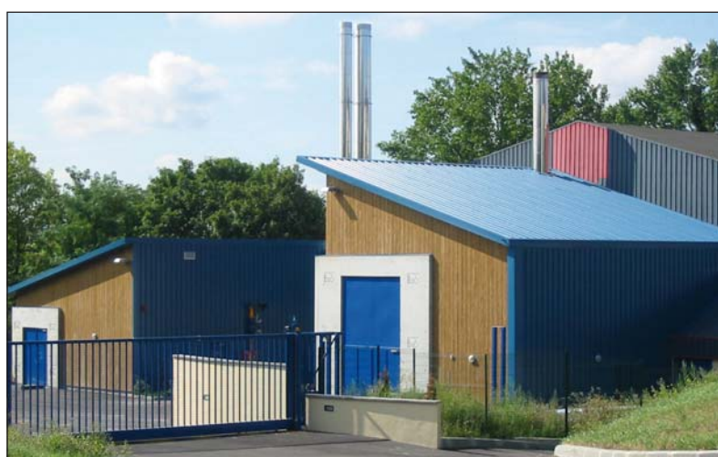
Chaufferie bois (au premier plan) et chaufferie gaz (au second plan).
