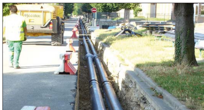
Tranchées réseau de chaleur.
