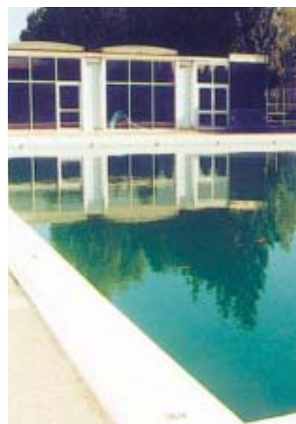
Bassin de la piscine solaire d'Ezanville.
