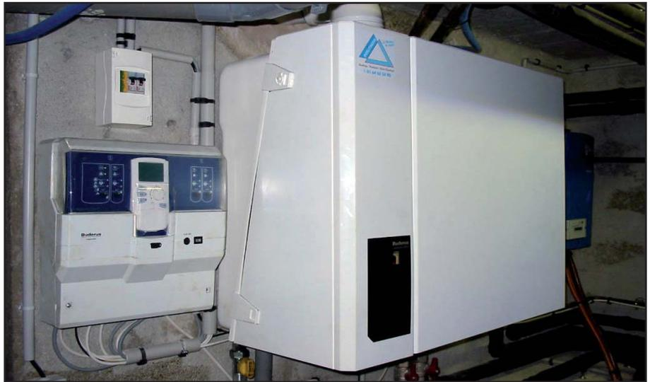
La chaudière gaz de 60 kW et la régulation.
