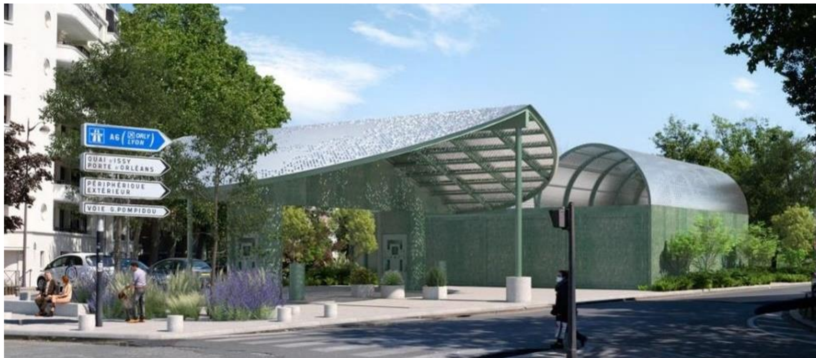
Station de production et distribution d'hydrogène de Porte de Saint-Cloud, Paris 16 (1 T/jour) © HySetCo, 2022
