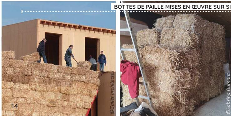
BOTTES DE PAILLE MISES EN ŒUVRE EN ATELIER : PRÉFABRICATION DE PAROIS
