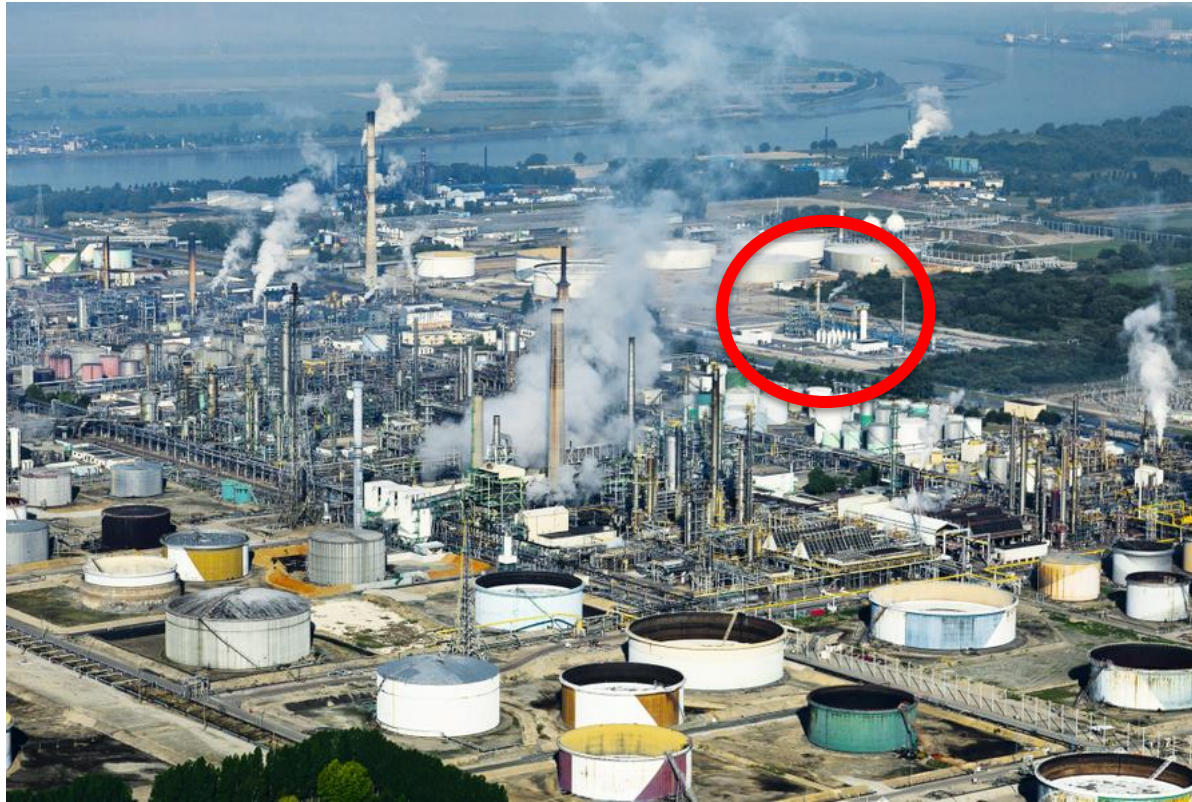
Plateforme industrielle (énergies, chimie) de Port-Jérôme sur Seine Au premier plan, dépôt pétrolier et raffinerie d'ExxonMobil Au second plan à droite, unité SMR d'Air Liquide (avec installation CCUS Cryocap TM – 100 000 T CO 2 / an)
