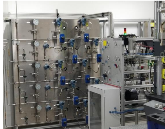
Plateforme de recherche FenHYx, sur l'injection d'hydrogène dans les réseaux gaz à Alfortville (94)
