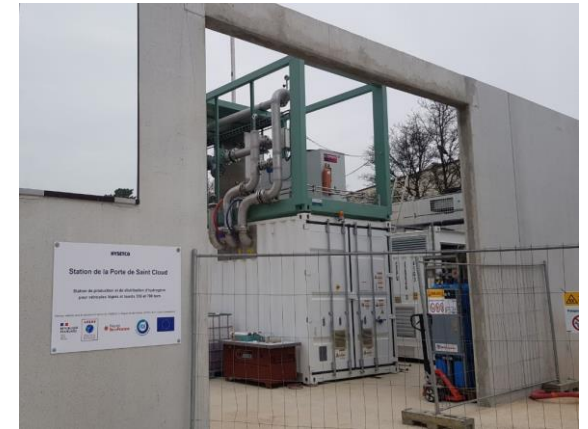
Chantier de la plus grosse station de production / distribution d'hydrogène (1 tonne / jour) à Porte de St-Cloud (Paris, 75)
