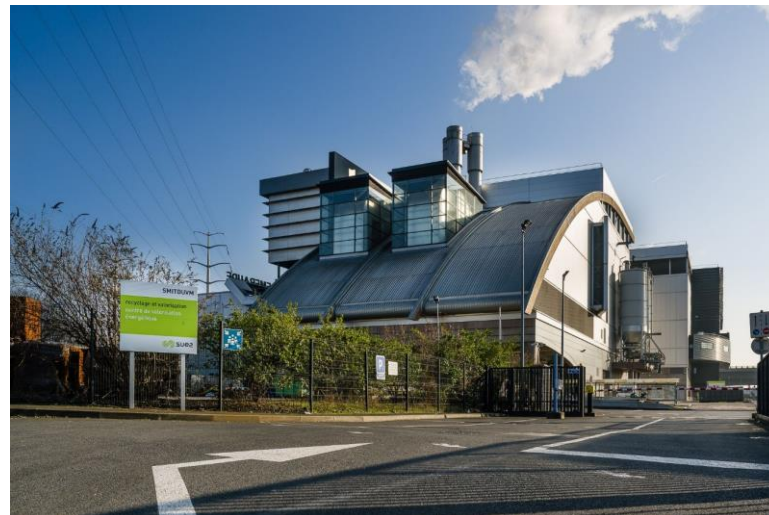
H2 Créteil, écosystème territorial hydrogène avec production d'hydrogène (500 kg – 1 T par jour), station et usages bus et BOM © Jérôme Baudoin/ SUEZ
