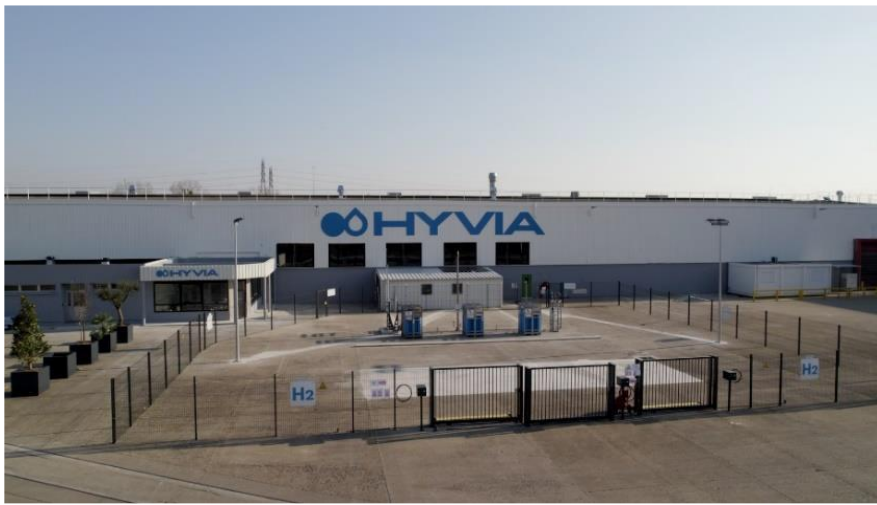
Inauguration du site industriel d'Hyvia sur Re-Factory Renault à Flins (78), assemblage de piles à combustibles et stations H2 pour véhicules utilitaires Master H2
