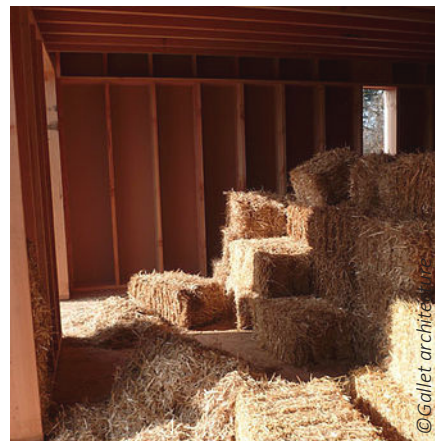
Bottes de paille mises en oeuvre sur site
