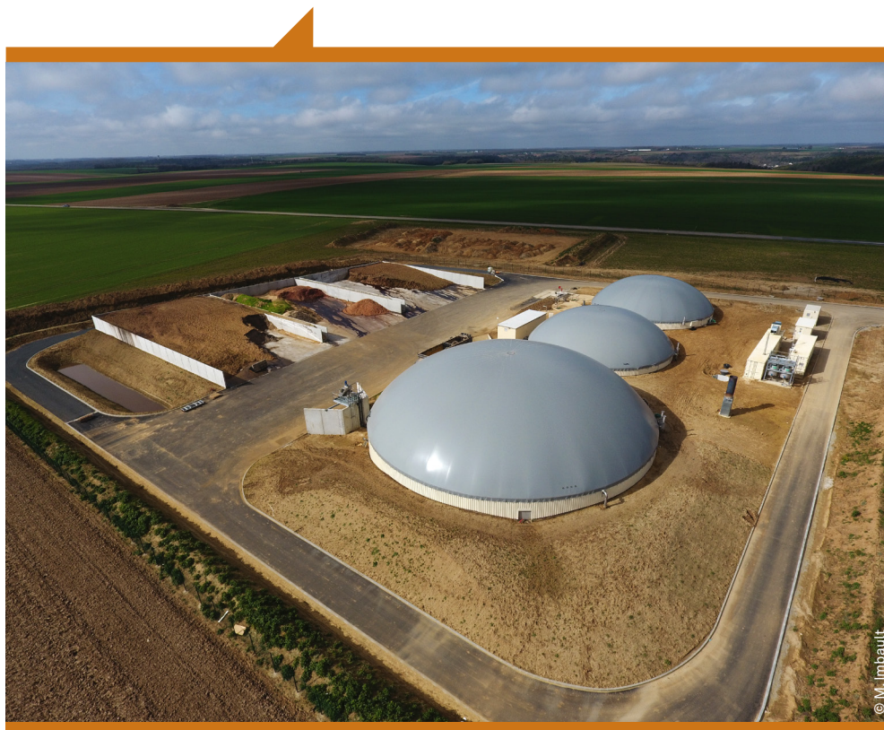
Unité de méthanisation d'Ormay-la-Rivière (91)
