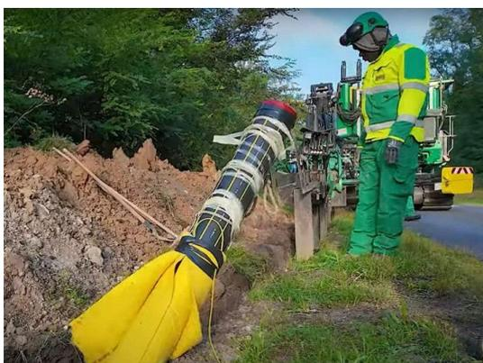
En Seine-et-Marne, GRDF débute un chantier pour l'installation d'une conduite en polyéthylène (PE) enrubanné de 8 km pour raccorder un site de méthanisation au réseau de gaz vert et ainsi d'alimenter les communes voisines en gaz vert.
