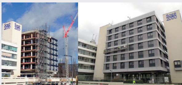
Durant les travaux
