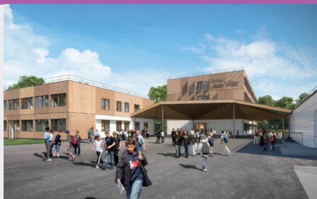
Collège Jean Vilar à Villetaneuse qui fait l'objet de travaux de rénovation visant à faire baisser la consommation énergétique de 40 %.
