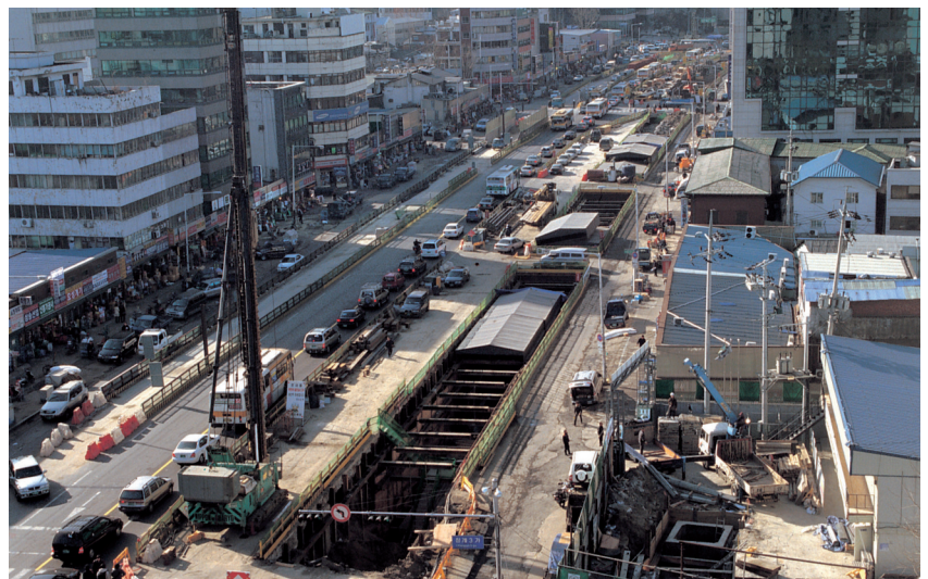
Le chantier en 2004 après démolition du viaduc © Seoul Metropolitan Government
