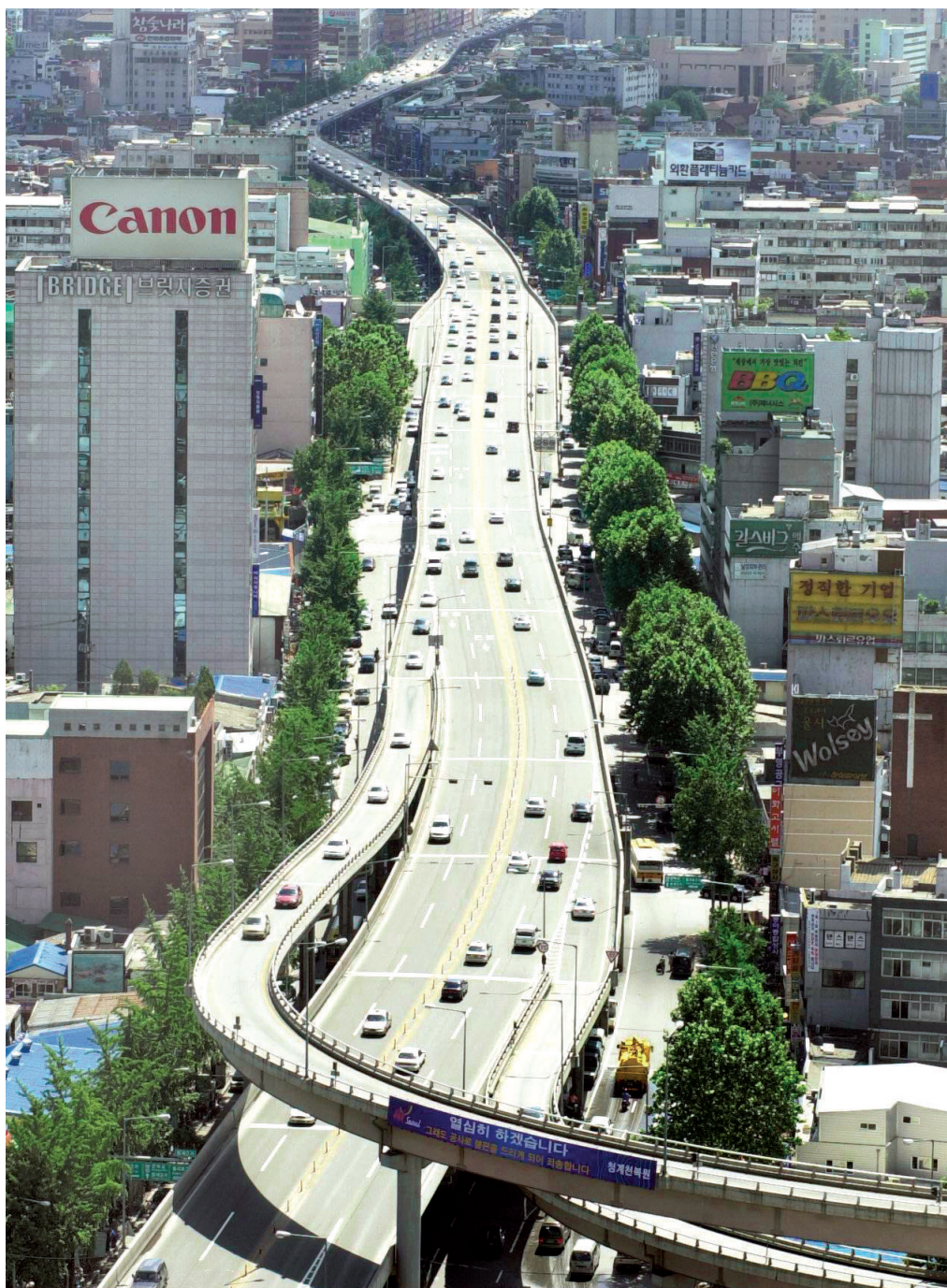
Avant 2003, un axe autoroutier qui coupe la ville en deux © Seoul Metropolitan Government
