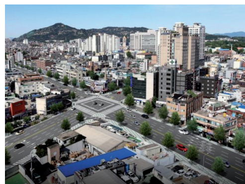
Avant / après de viaduc démolit © Séoul Metropolitan Government
