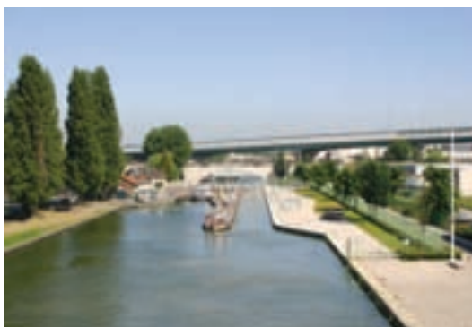
Aménagements «piétons-cycles», en rive droite du canal Saint-Denis Source : C. Legenne - laurif
