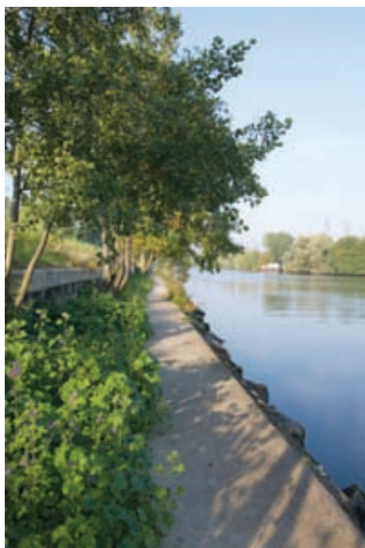
Promenade actuelle en berges à Rueil-Malmaison Source : CG92 - DAUDD
