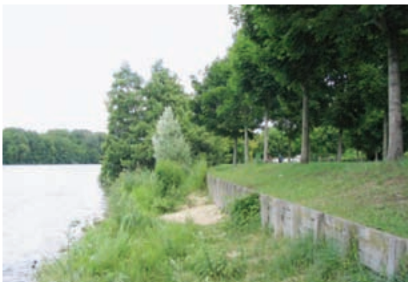
Berge avec tunage à Héricy et phénomène d'érosion. source IAURIF/ E.Bordes-Pagès
