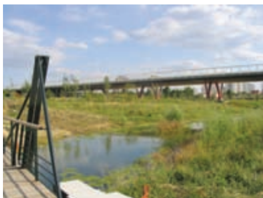
«Parc du chemin de l'île» à Nanterre, le contre-fossé augmente les capacités du parc et sert de zone d'expansion de crue Source : laurif - EBP
