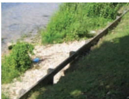
Berge avec tunage à Héricy et phénomène d'érosion. source IAURIF/ E.Bordes-Pagès
