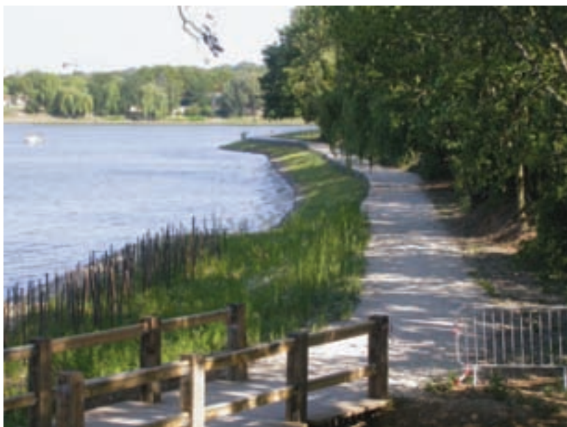
Relier la Seine au lac de Viry-Grigny. Aménagement des berges du lac. Mise en œuvre de techniques de génie végétal.
