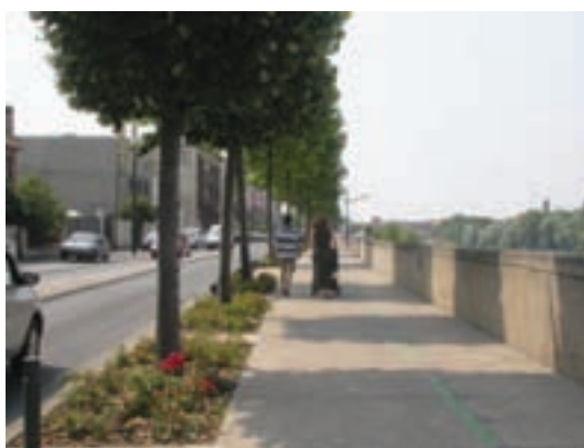
Alfortville, quai Blanqui - Aménagement du quai bas et de la promenade haute (trottoir «piétons-vélos», plantations...)
