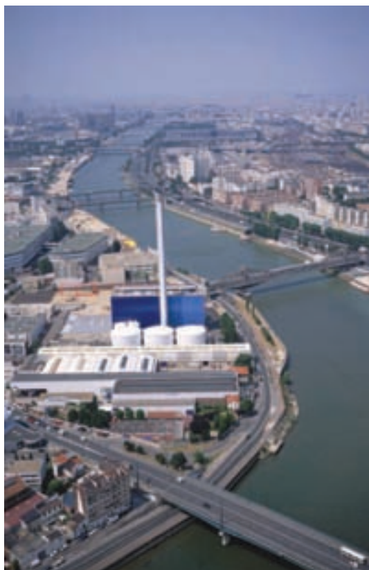
Le quai Auguste Deshaies à Ivry-sur-Seine Source : laurif - P. Guignard
