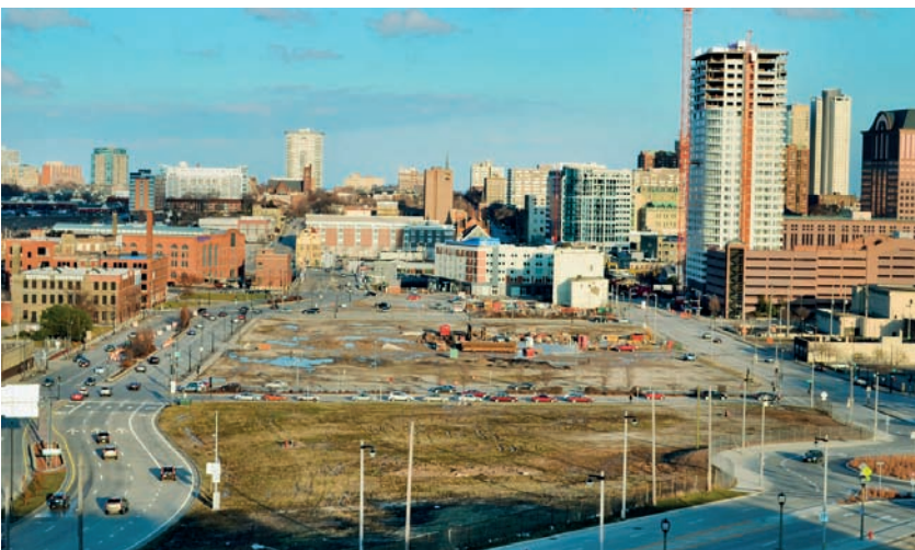
Le corridor de l'ex-autoroute Park East se construit peu à peu. À droite la McKinley Avenue ; à gauche, la tour The Moderne en construction en 2012. © Urban Milwaukee - DR
