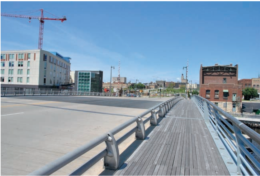
Le nouveau pont réalisé suite à la démolition de l'autoroute en prolongement de la McKinley Avenue. © P. Lacroix IAU îdF
