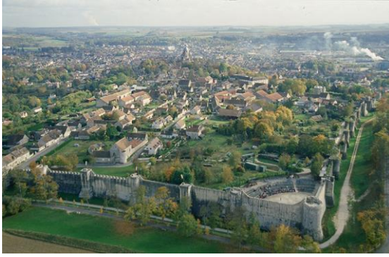
Vue aérienne de la cité médiévale de Provins : au premier plan les remparts et son théâtre, en arrière-plan, la tour César et la collégiale Saint-Quiriace. © DRIEA/GUIHO
