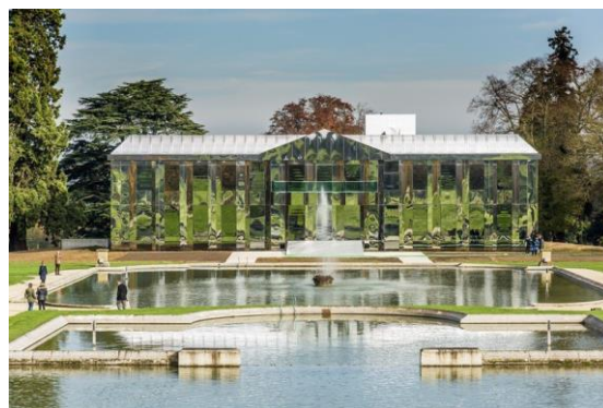
Le château de Rentilly réhabilité © Martin Argyroglo
