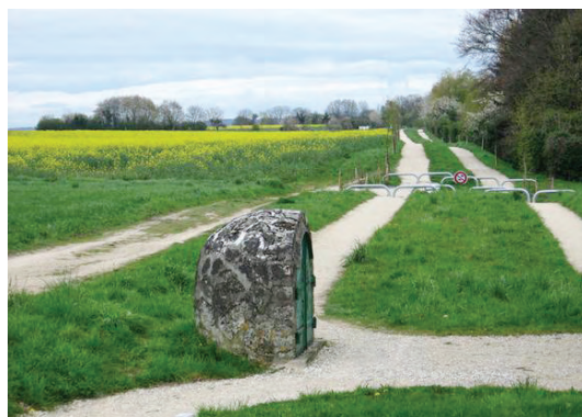
Passage de l'aqueduc de la Dhuis en limite de Dampmart, © L. Nolorgues, IAU idF, 2008
