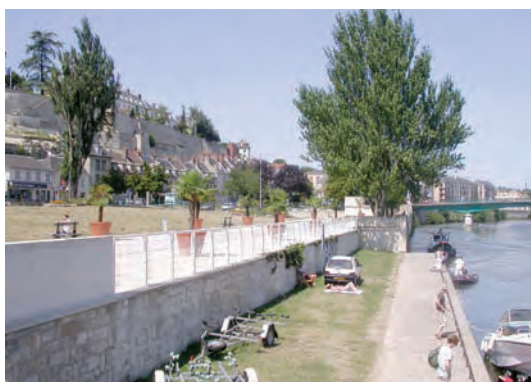
Espace public du Quai Fontaine. Détail de l'aménagement entre quai haut et l'embarcadère © EBP, IAU îdF, 2007
