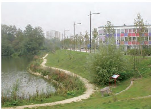
Collège et quartier d'habitat collectif aux abords du Parc du Pâtis © EBP, IAU îdF, 2007
