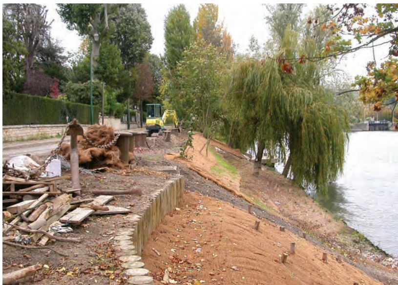
Opération de renaturation des berges à Croissy-sur-Seine
