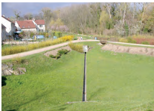
Bassin de rétention sur le rû de Liesse entre lotissements et espaces naturels, vue vers l'aval. © EBP, IAU idF, 2008
