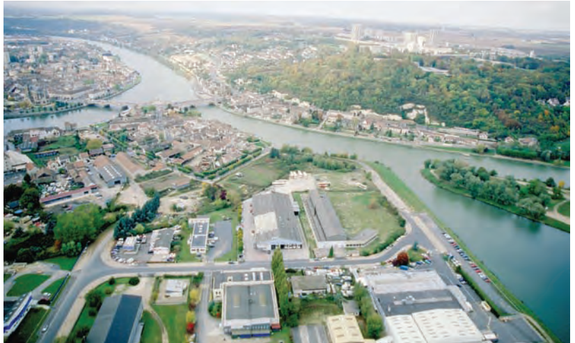
L'implantation de Montereau à la confluence de la Seine et de l'Yonne. En premier plan à droite, la zone industrielle et l'entrée du port avec sa darse. © DREIF, Guiho, 2000
