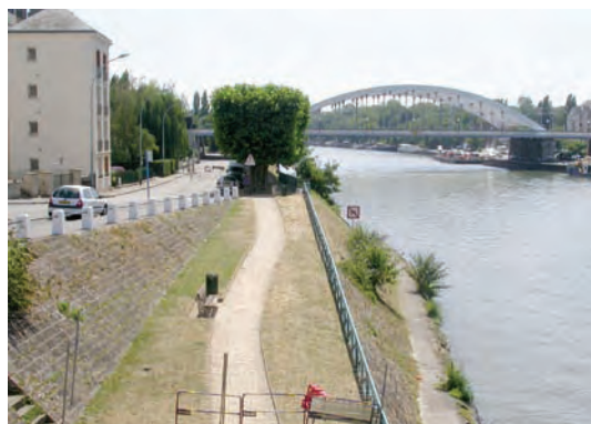
Aménagement de la berge à la hauteur du pont de Saint-Ouen-l'Aumône, © EBR, IAU îdF, 2008
