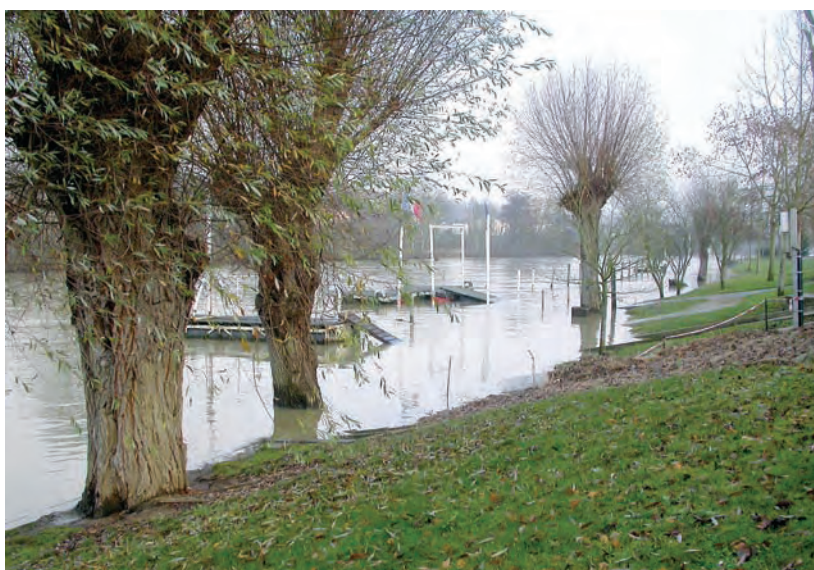
Embarcadère au niveau de la Société nautique et berge aménagée. Photo prise au moment d'une crue légère. © EBP, IAU îdF, 2007
