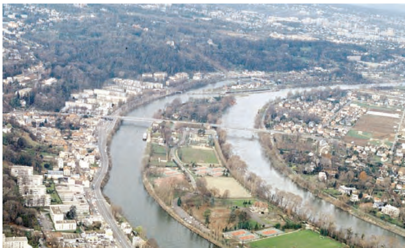
Le site de Croissy-sur-Seine. L'ancien tracé de la machine de Marly et l'aqueduc qui permettaient d'alimenter Versailles en eau sont visibles en rive gauche. Se succèdent sur la Seine, l'île de Bougival, l'écluse et l'île de la Loge au 2 ème plan. © DREIF, Guiho, 1984
