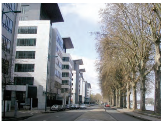
Immeubles de bureaux face à la Seine, le long de la voirie départementale, à Saint-Ouen © EBR, IAU îdF, 2008
