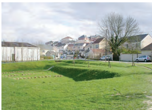
Bassin de rétention sur le rû de Liesse, vue amont vers le nouveau programme immobilier « Blanche de Castille » © EBP, IAU idF, 2008
