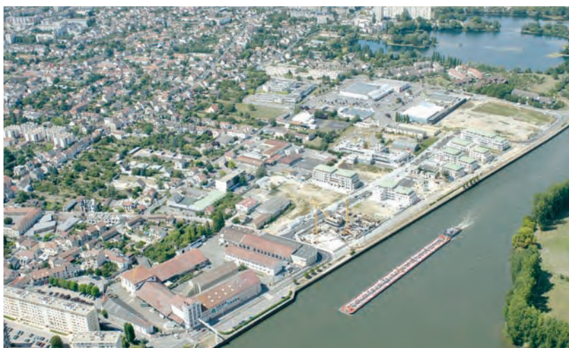
Le nouveau quartier de la ZAC Bords de Seine en construction et le site Dunlopilo, futur site de renouvellement urbain © DREIF, Gauthier, 2005
