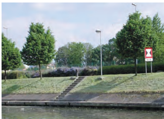
Exemples d'aménagement de berges le long de la Marne et au sein du port: berge paysagée et berge en perré recouvert de végétal. © Ports de Paris, 2008
