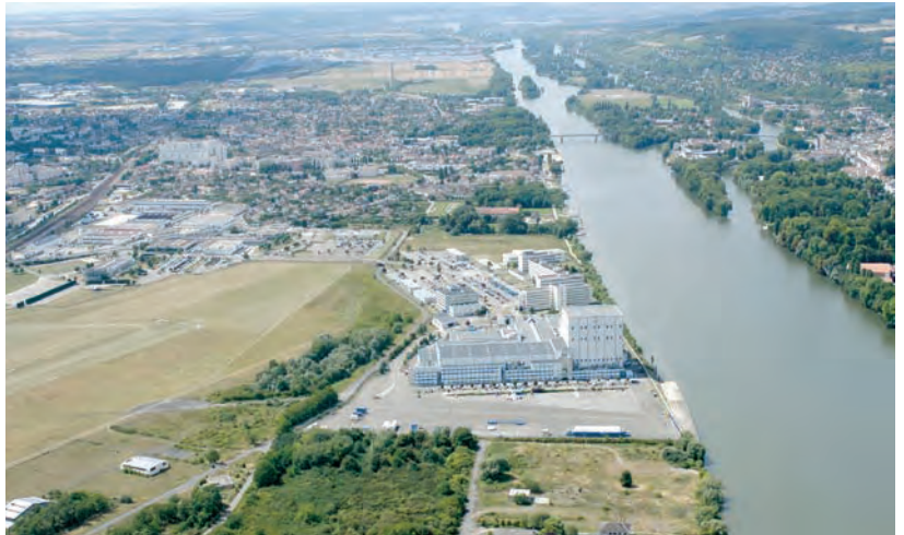
Plus de la moitié du linéaire de berges est occupée par des activités économiques (industrie aérospatiale, EADS, station d'épuration et aérodrome ...) ou des friches. Sur le linéaire restant, se côtoient de nombreux espaces verts © DREIF, Gobry
