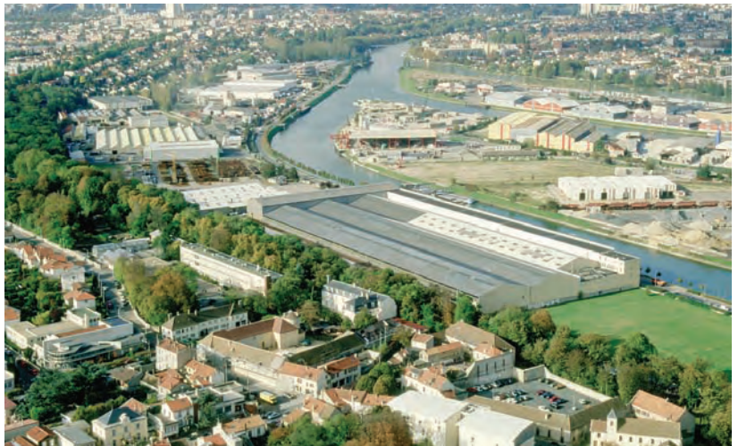
Sur les coteaux, la ville de Bonneuil et le parc du Rancy dominant les installations portuaires situées en rive gauche de la Marne © DREIF, Guiho, 2000
