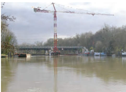
Deux paliers d'eau à mettre en valeur. Ici l'écluse de Pontoise © EBP, IAU idF, 2007
